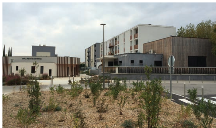
Construction Pôle Petite Enfance et Espace Josette Roche
