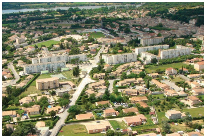
Vue aérienne du quartier de l'Enclos avant travaux
