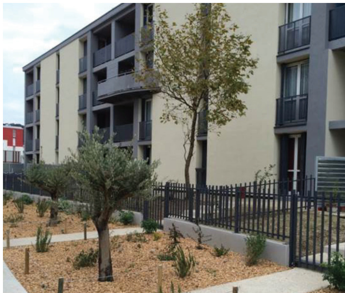
Réhabilitation bâtiments G et I
