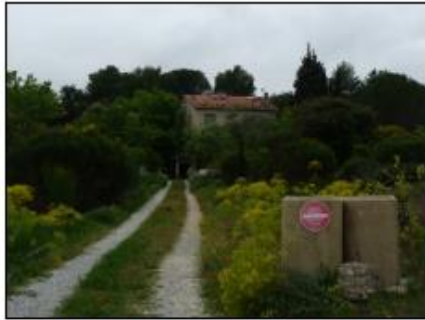
Maison R+1 en contrebas de l'éperon rocheux
