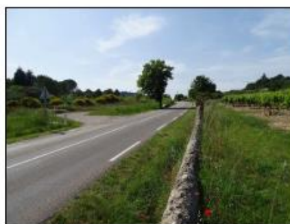
Muret en pierres le long de la RD 538
