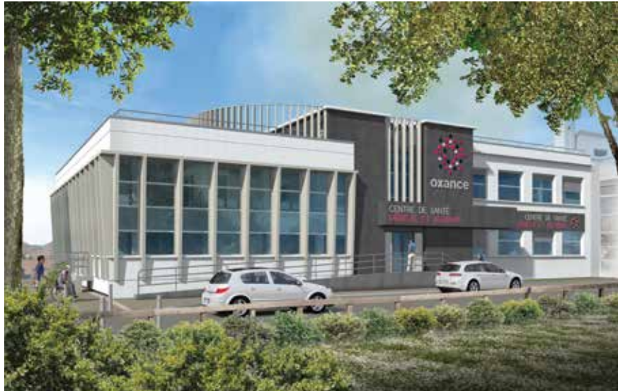
À Romans-sur-Isère, DAH est le maître d'ouvrage délégué du futur centre de santé.
