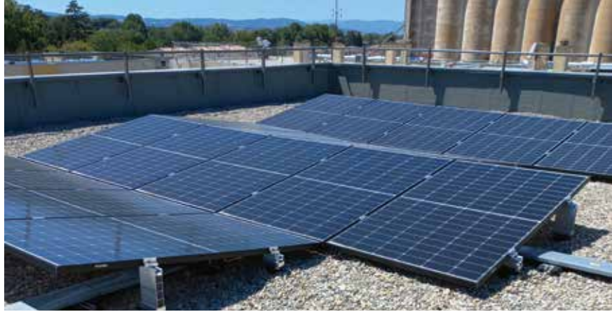
À Crest, des panneaux photovoltaïques ont été installés sur le toit de la résidence La Prairie.
