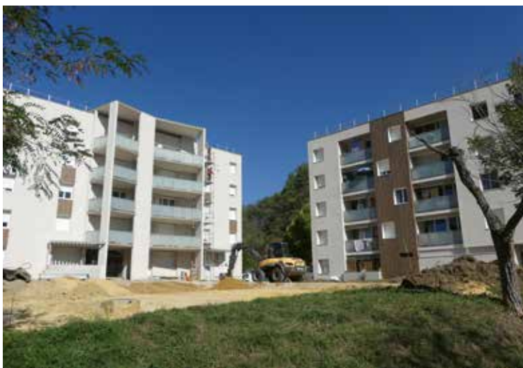
À Dieulefit, DAH réhabilite la résidence Les Reymonds de 62 logements.
