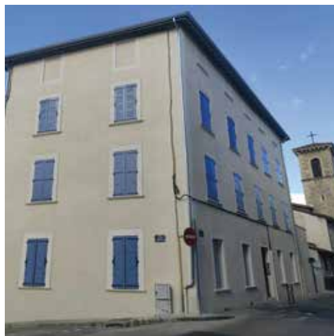
À Romans-sur-Isère, DAH a livré en 2025 la résidence Tour Saint-Nicolas qui compte 6 logements réhabilités.
